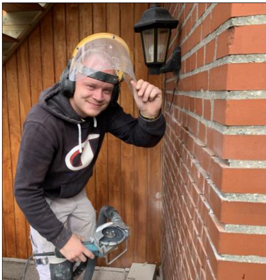
Rasmus Christensen Eskesen er i gang med at renovere murværket på Horne Kro.
